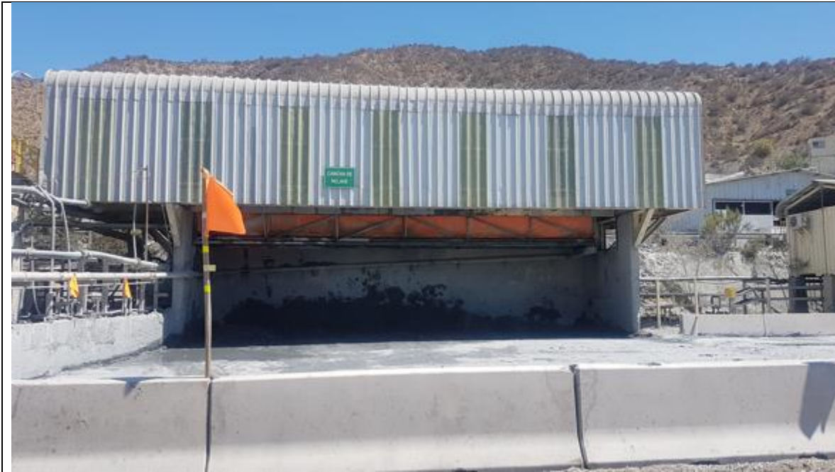
Barrera de hormigón New Jersey Instalada
