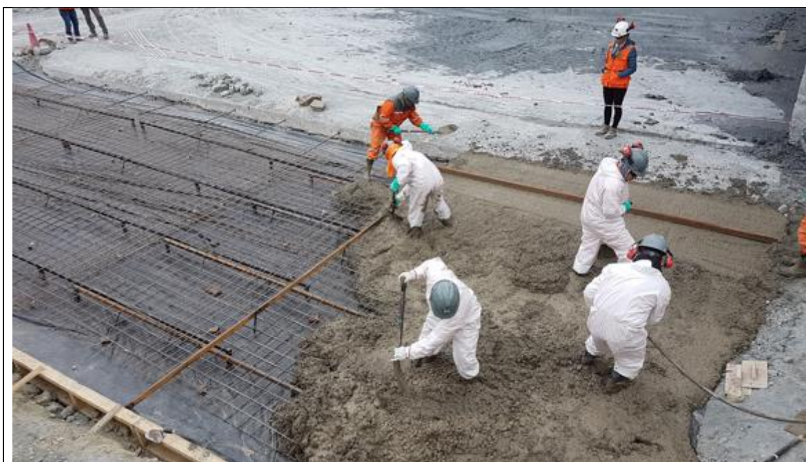
Constucción de la Losa en área de relaves
